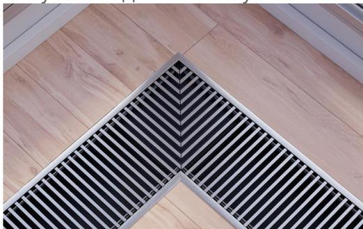
Конвекторы в угловом исполнении с поперечными решётками. Решётки стыкуются между собой под углом 45°. Требуется применение дополнительной ванны, а также угловой решётки. ПО поводу расценки просим обращаться в офис «Верано».
